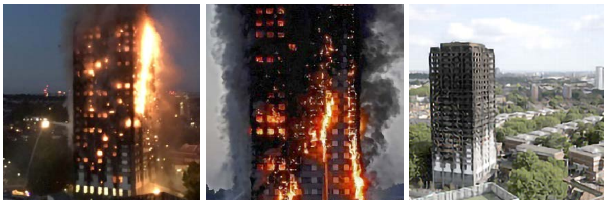
Obr. 1. 5 Průběh požáru výškové budovy v Londýně ( http://www.topky.sk/ , 2017)
