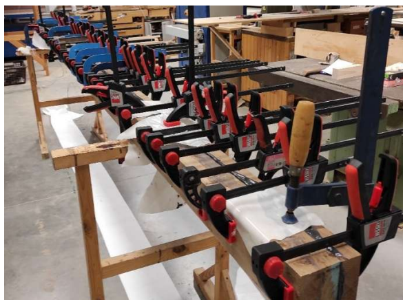
Obr. 57 Lepení 3 lamely - kompletace modifikovaného nosníku
