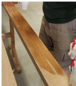
Obrázek 53 Penetrování kontaktní ploch lamel
