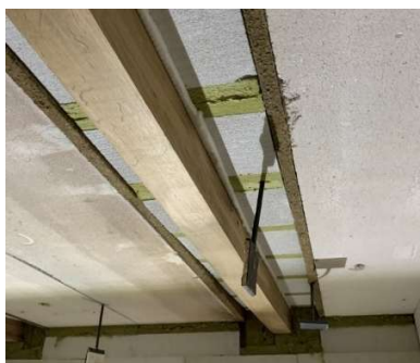
Obr. 63 Detail nosníku v peci
