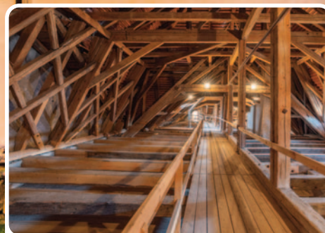
Jedinečně dochovaný dřevěný krov.
